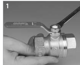
1 Die Mutter mit einem geeigneten Schlüssel lösen
