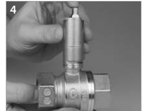
4 Den Mittelstift der Verlängerung auf die Kugelhahn-Stange schrauben und mit dem Hebelgriff des Kugelhahns fest anziehen.
